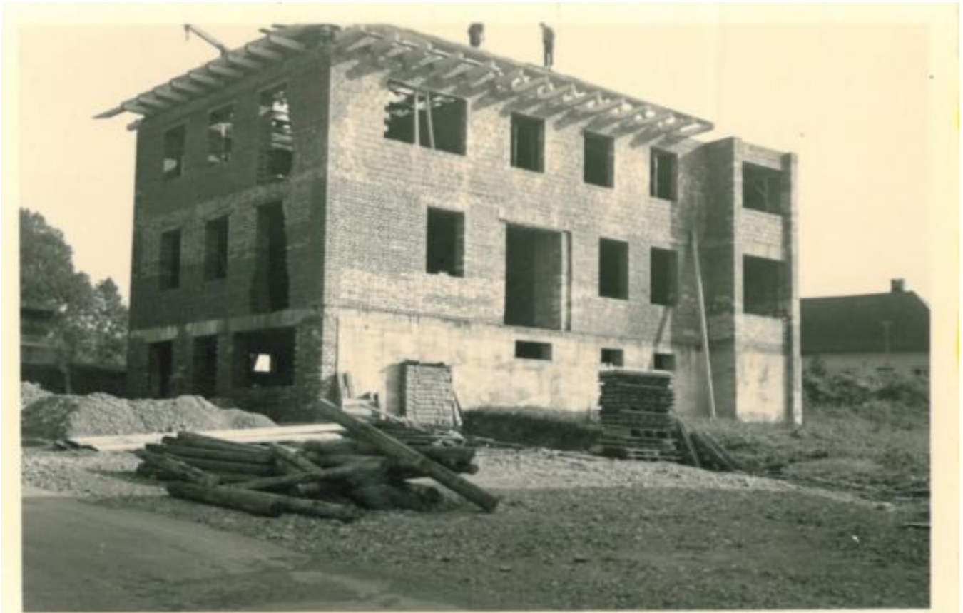
Foto: Das Amtshaus im Rohbau
